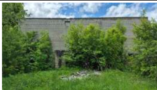
Būve (katlu māja) ar kadastra apzīmējumu 4642 002 0060 008
