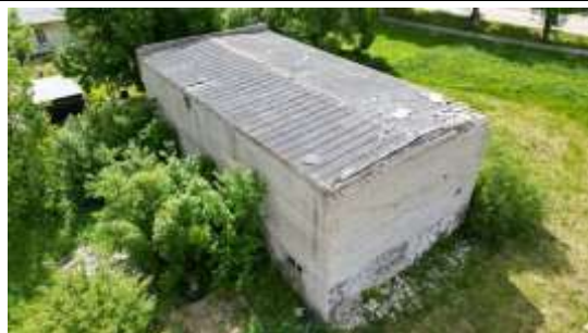
Būve (katlu māja) ar kadastra apzīmējumu 4642 002 0060 008
