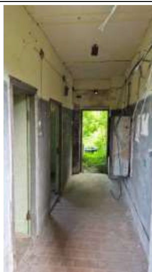
Būve (katlu māja) ar kadastra apzīmējumu 4642 002 0060 008
