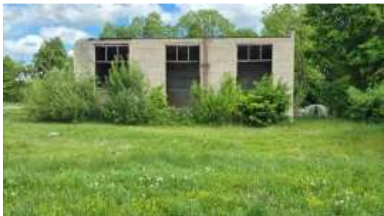
Būve (katlu māja) ar kadastra apzīmējumu 4642 002 0060 008
