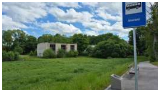
Būve (katlu māja) ar kadastra apzīmējumu 4642 002 0060 008
