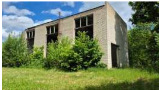
Būve (katlu māja) ar kadastra apzīmējumu 4642 002 0060 008
