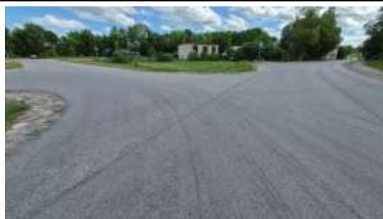
Valsts reģionālais autoceļš P97 Jelgava – Dobeles – Annenieki
