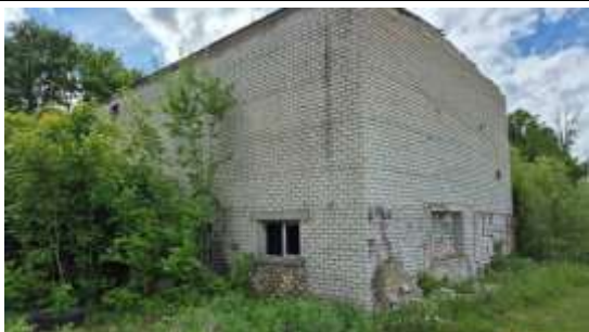
Būve (katlu māja) ar kadastra apzīmējumu 4642 002 0060 008
