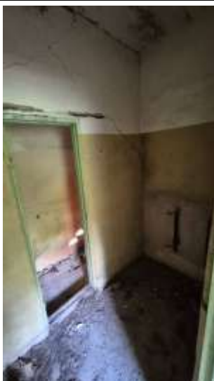
Būve (katlu māja) ar kadastra apzīmējumu 4642 002 0060 008
