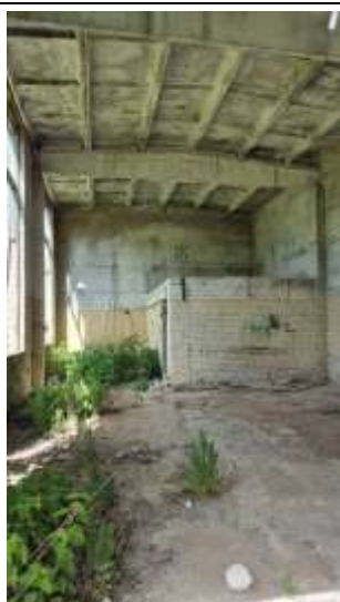
Būve (katlu māja) ar kadastra apzīmējumu 4642 002 0060 008
