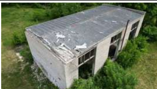
Būve (katlu māja) ar kadastra apzīmējumu 4642 002 0060 008
